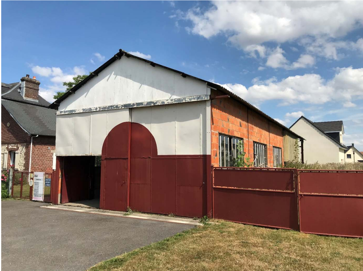
Photographie de l'ancien garage à démolir
