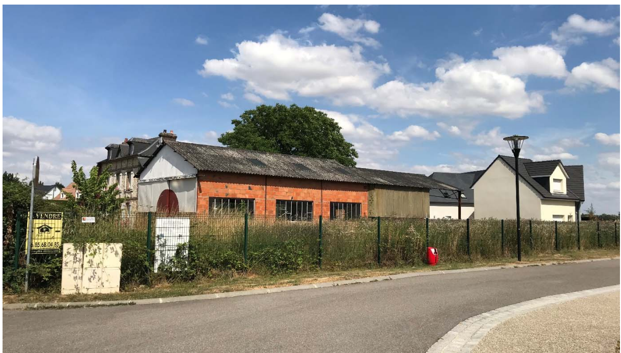
Photographie de l'ancien garage à démolir
